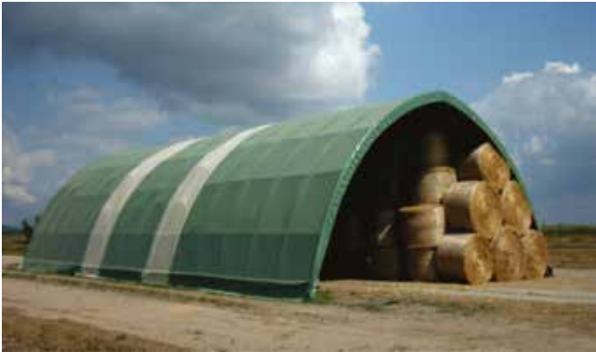
Bogenhalle als Strohlager
