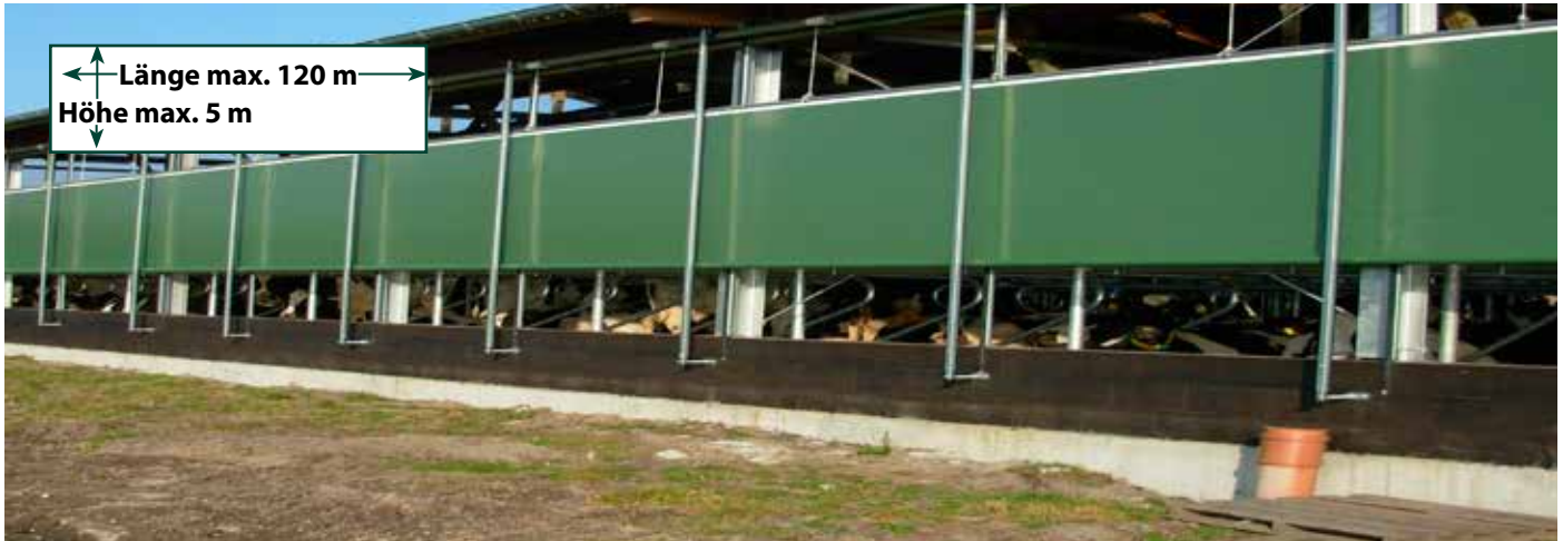
Seitenwandaufrolltechnik in Beschattungsposition
