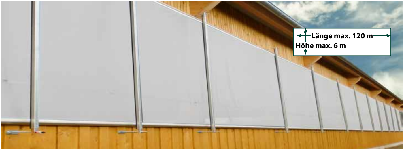
Seitenwandaufrolltechnik mit transparenter Windschutzplane an einem Holzstall
